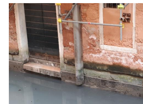
Interventi di presidio delle porte d'acqua già realizzati da Generali (+1.95 cm z.m.p.s.)
